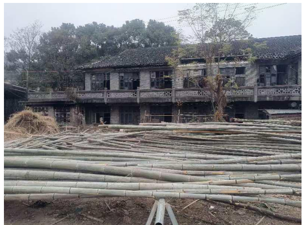
铁合金厂内废弃厂房及空地
